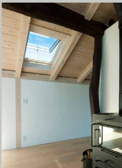
Samostatné osadenie medzi krokvami.
